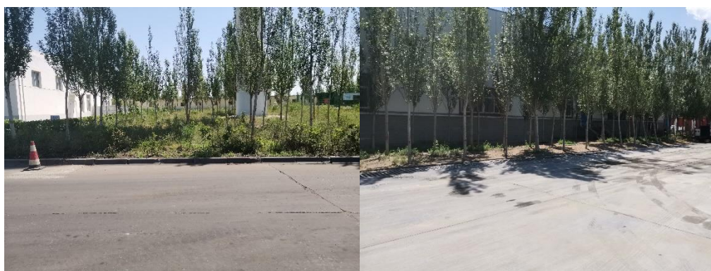
附属设施排水沟及绿化措施
