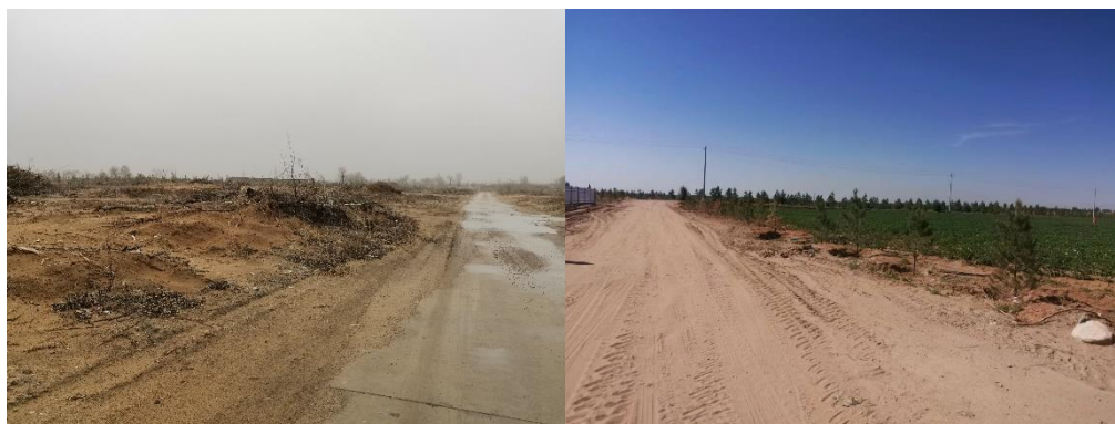
2号风井进场道路治理前后
