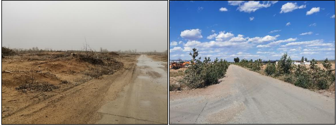
2号风井进场道路治理前后
