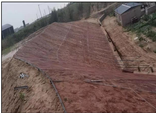
边坡防护（铁丝网片、碎石）
