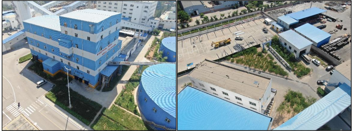
主工业场地植物措施
