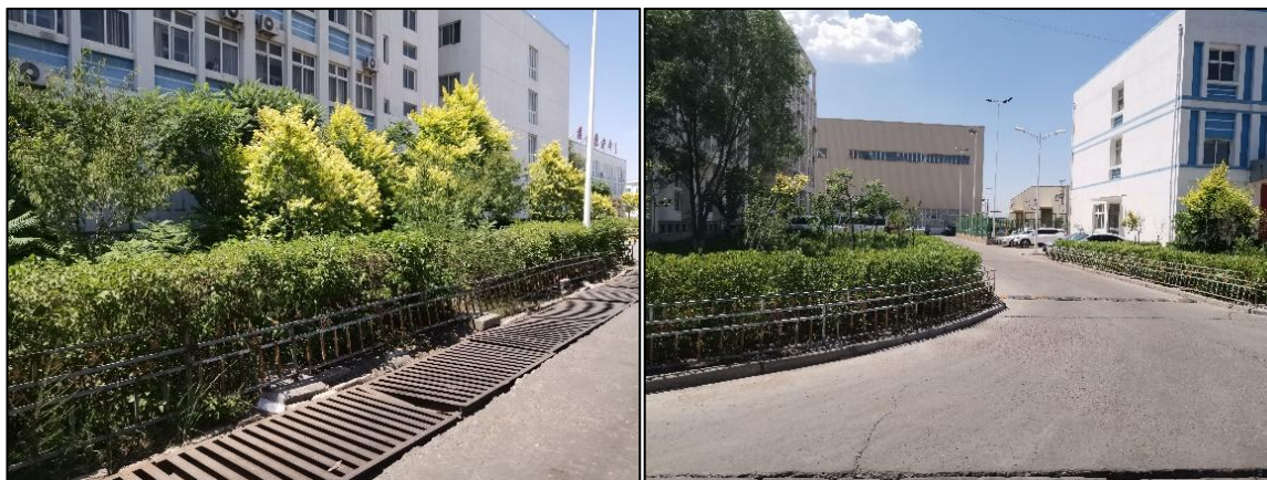
附属设施排水沟及绿化措施
