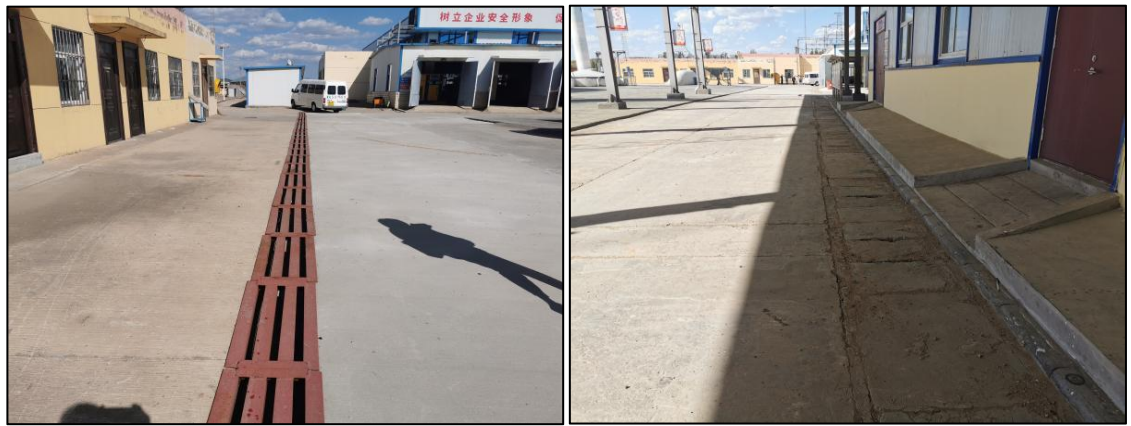
2号风井场地排水沟
