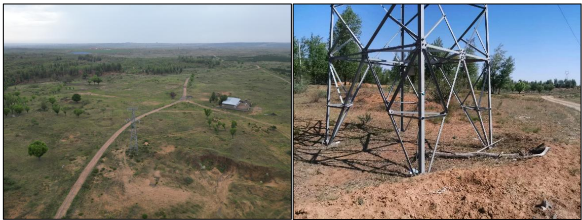
供电线路绿化措施
