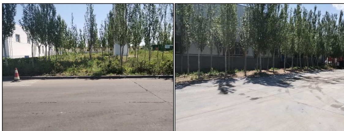
附属设施排水沟及绿化措施
