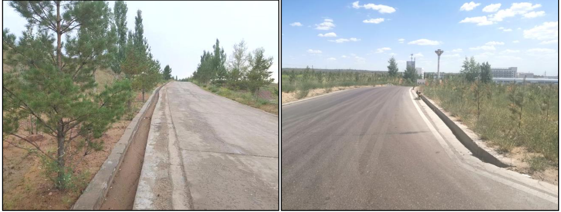
渣场排水工程
