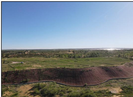
边坡防护（铁丝网片、碎石）
