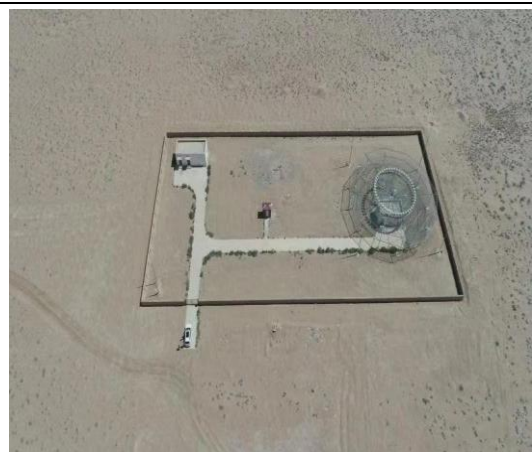
右旗导航站全景照片
