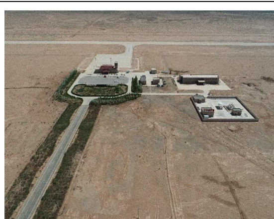
右旗外部施工道路砾石压盖
