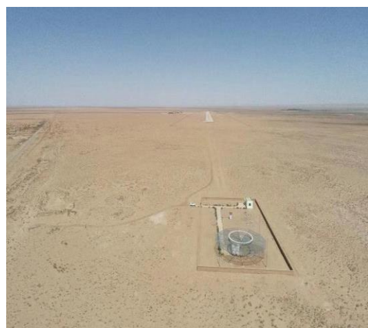
右旗导航站外供电及通信线路恢复原地貌
