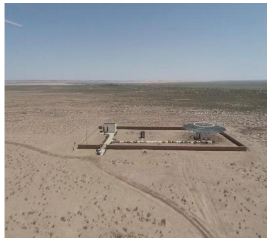
右旗导航站施工便道
