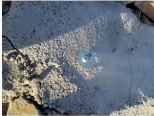
照片 5 弃土场沉降观测点
