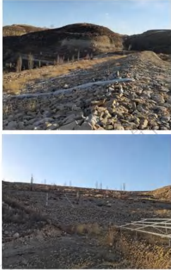
照片1 弃土场边坡
