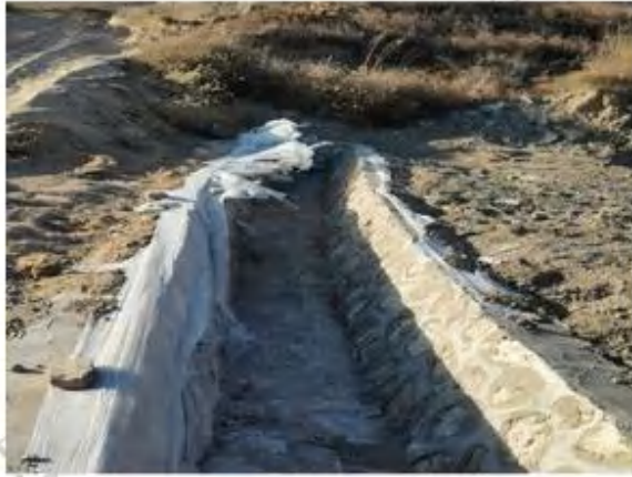
照片3 弃土场排水沟
