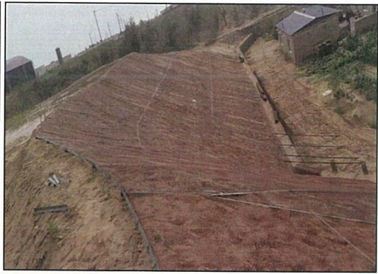
边坡防护（铁丝网片、碎石）
