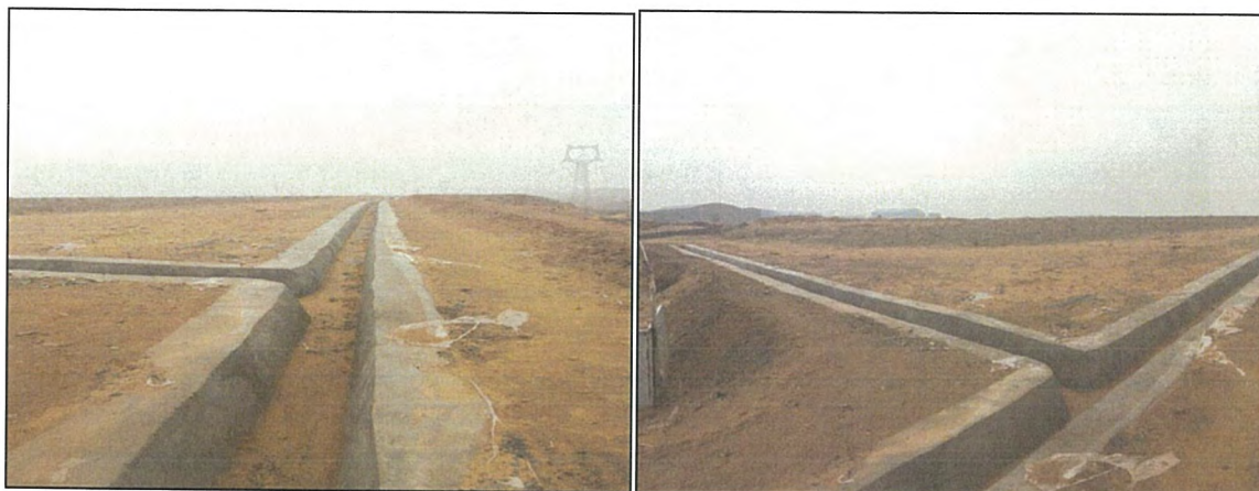
渣场排水工程
