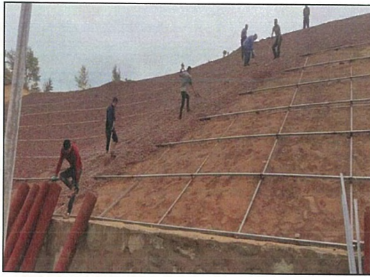
边坡防护（铁丝网片、碎石）
