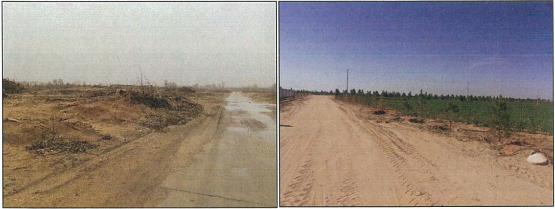
2号风井进场道路治理前后
