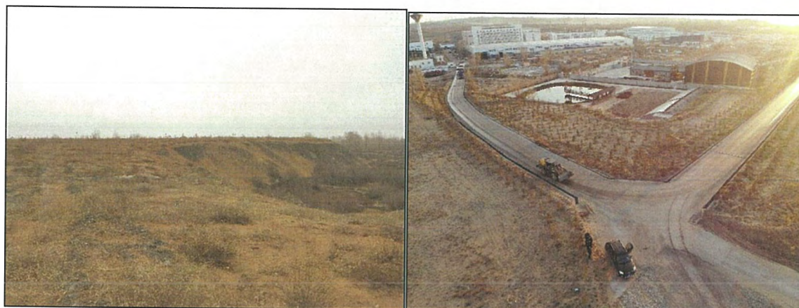
弃渣场治理前后
