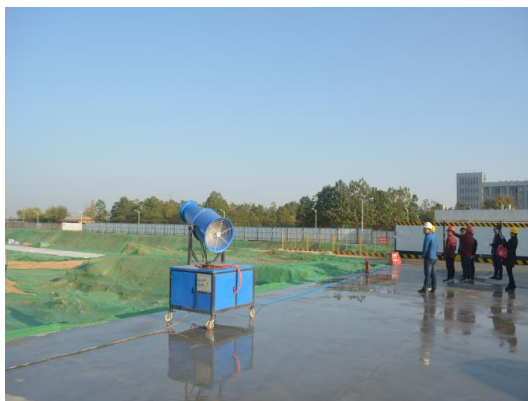
照片拍摄 2017 年 9 月 11 日，监测位置为飞行区东联络通道施工现场，现场描述：雨中查看工地。
