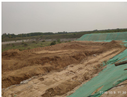
照片拍摄 2018 年 8 月 26 日，监测位置为调节池，监测点现场描述：调节池开挖。
