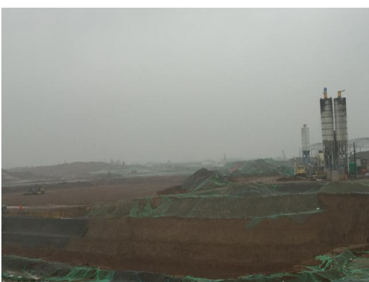
照片拍摄 2018 年 3 月 2 日，监测位置为飞行区东联络通道，现场描述：表土剥离。
