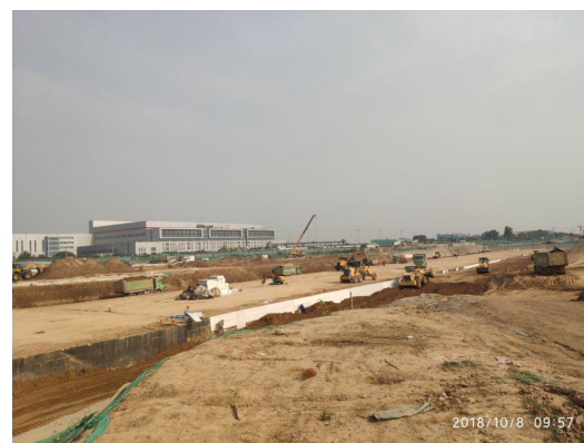
照片拍摄 2018 年 8 月 26 日，监测位置为飞行区，监测点现场描述：土方回填。
