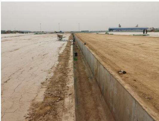
照片拍摄 2018 年 12 月 29 日，监测位置为飞行区，监测点现场描述：矩形排水明渠。
