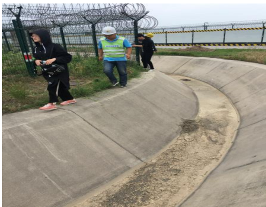
照片拍摄 2018 年 7 月 2 日，监测位置为飞行区，监测点现场描述：场外排水沟。
