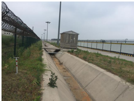
照片拍摄 2018 年 7 月 2 日，监测位置为飞行区，监测点现场描述：场外排水沟。
