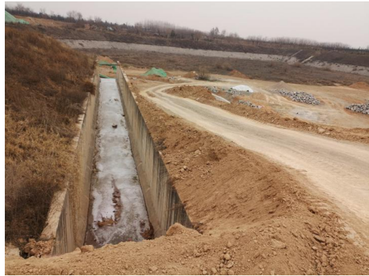
照片拍摄 2018 年 12 月 29 日，监测位置为调节池区，监测点现场描述：调节池水渠
