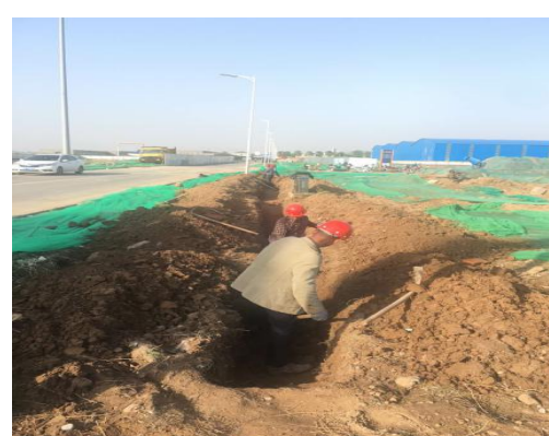
照片拍摄 2018 年 7 月 2 日，监测位置为场外排水区，现场描述：排水沟开挖
