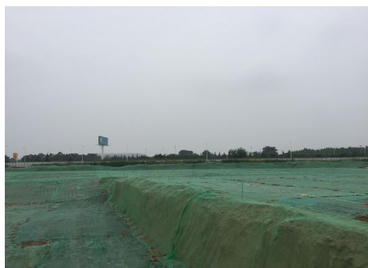
照片拍摄 2017 年 8 月 11 日，监测位置为飞行区东联络通道工地，现场描述：施工场地临时苫盖。
