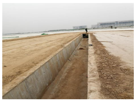
照片拍摄 2018 年 12 月 29 日，监测位置为飞行区，监测点现场描述：矩形排水明渠。
