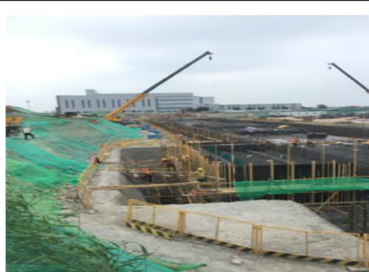
照片拍摄 2018 年 5 月 12 日，监测位置为飞行区东联络通道，现场描述：主体工程施工场地临时防护。
