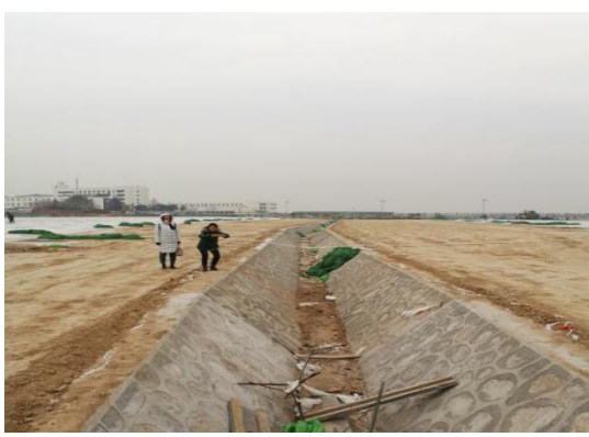
照片拍摄 2018 年 12 月 29 日，监测位置为飞行区，监测点现场描述：梯形排水明渠。
