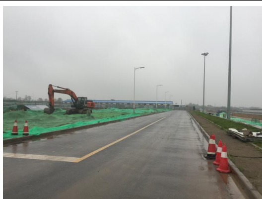
照片拍摄 2018 年 5 月 12 日，监测位置为飞行区巡场道路，现场描述：巡场道路。
