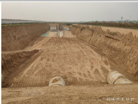
照片拍摄 2018 年 8 月 26 日，监测位置为调节池，监测点现场描述：调节池开挖。
